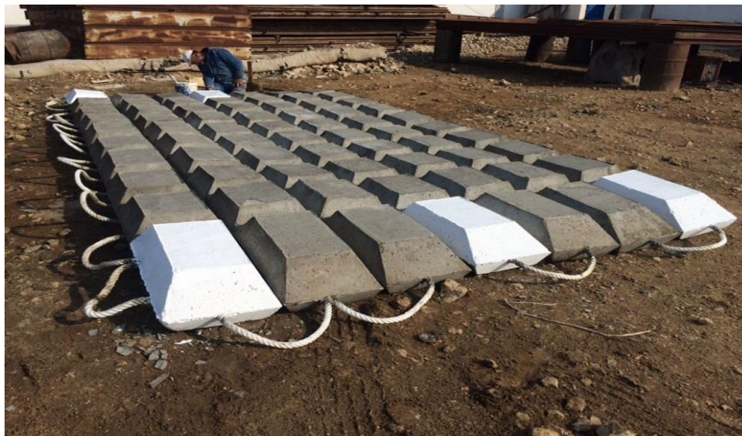
Gambar 2.6 Proses pembuatan matras beton
