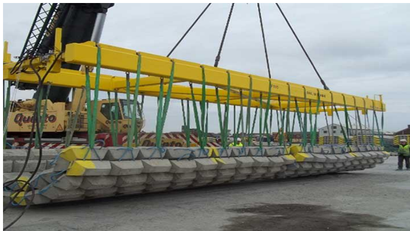
Gambar 2.7 Proses pengangkutan menuju lokasi pemasangan / instalasi
