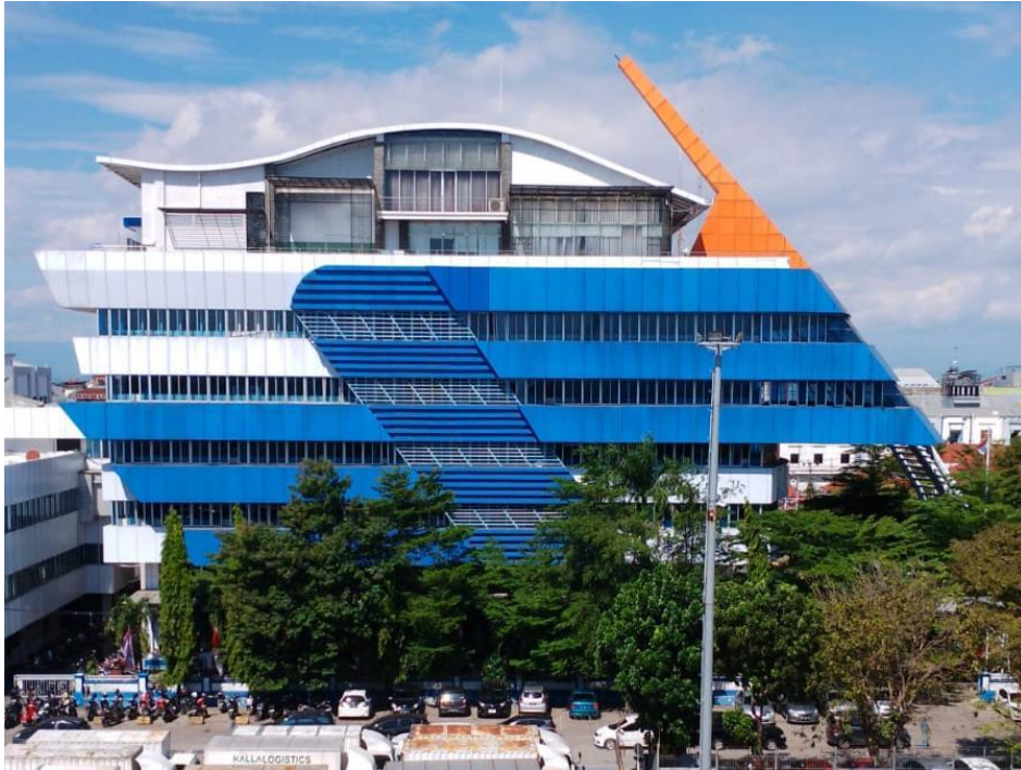
Gedung Kantor PT. Pelindo Reg IV
