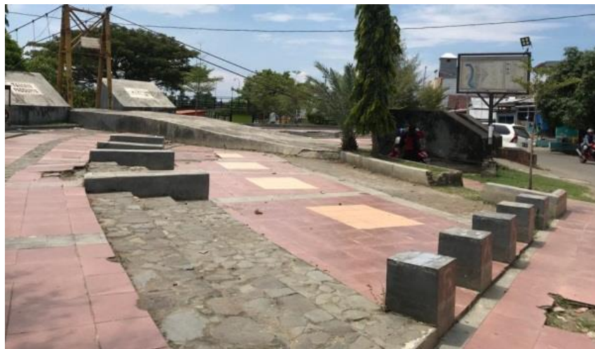
Tempat duduk berbahan beton
