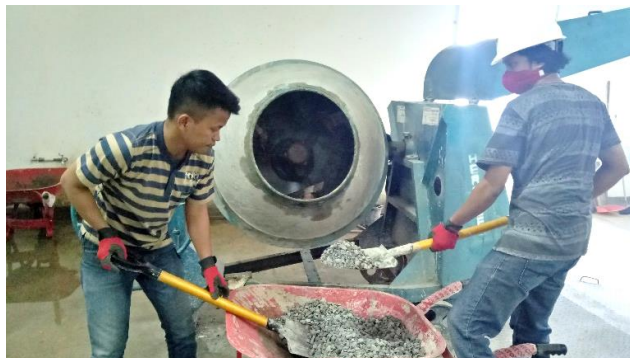
Gambar 6.17 Proses Pencampuran Material Beton
