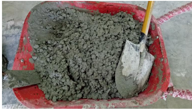
Gambar 6.18 Campuran Beton yang Siap Cetak
