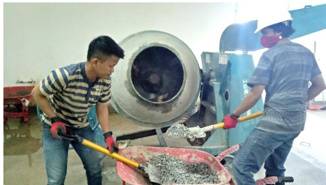
Gambar 4.11 Proses Pencampuran Material Beton
