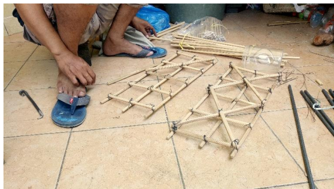
Gambar 6.13 Perakitan Tulangan Anyaman Bambu
