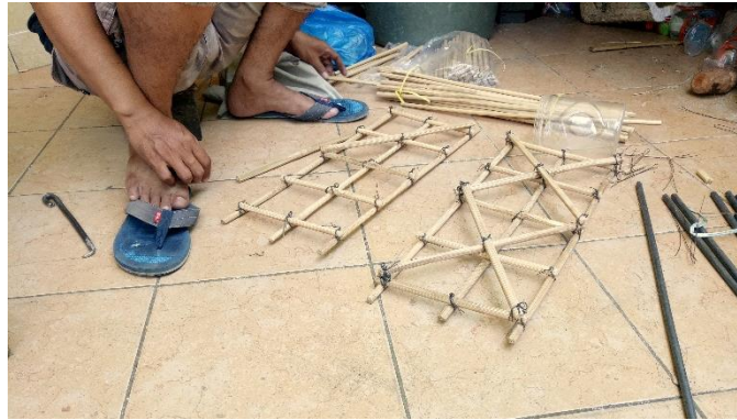
Gambar 4.8 Perakitan Tulangan Anyaman Bambu
