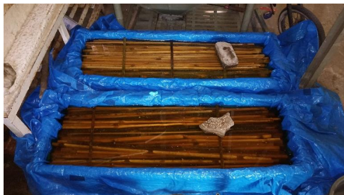
Gambar 6.10 Perendaman Bambu dengan Bahan Pengawet
