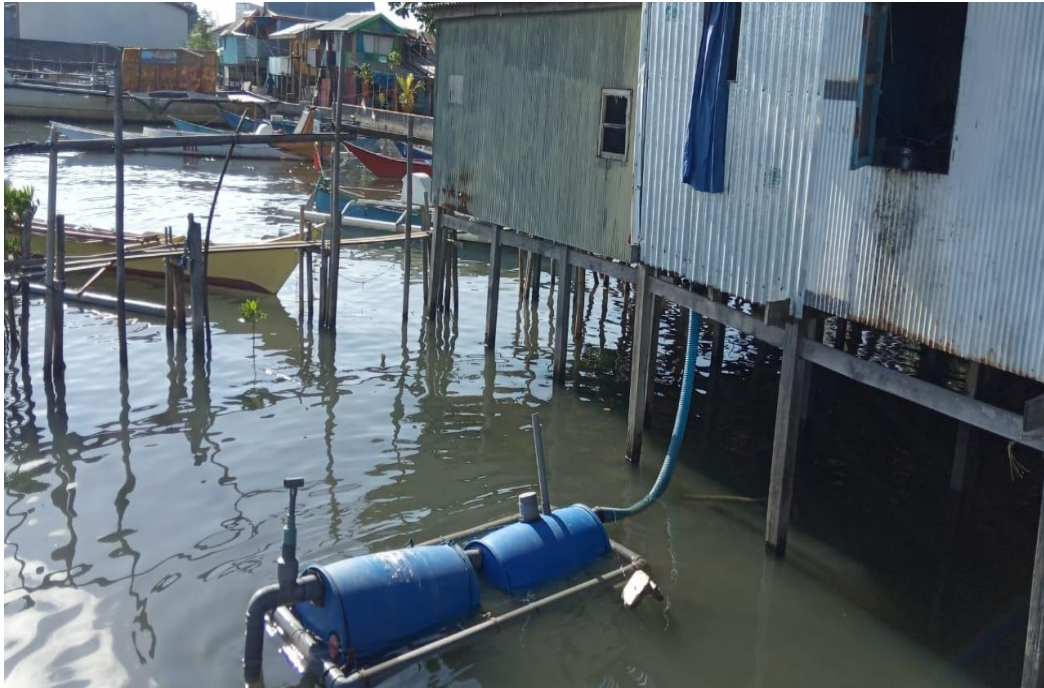
Gambar 4. Pemasangan Septik Tank Apung
