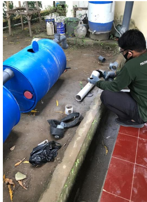
Gambar 3. Proses Pembuatan Septik Tank Apung
