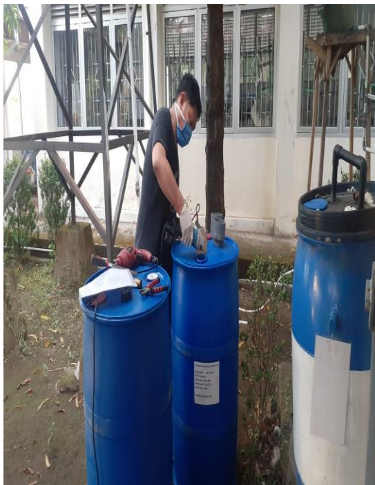
Gambar 3. Proses Pembuatan Septik Tank Apung
