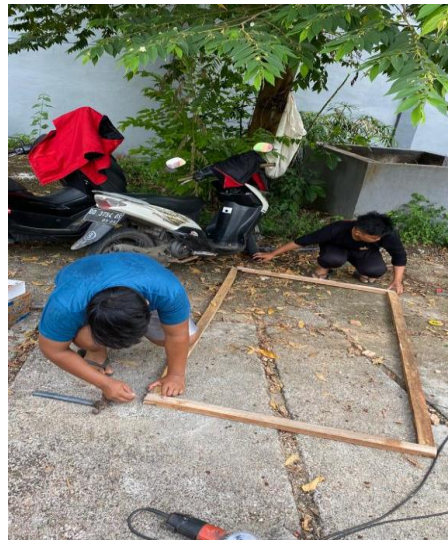
Gambar 14. Proses pembuatanudukan panel surya
