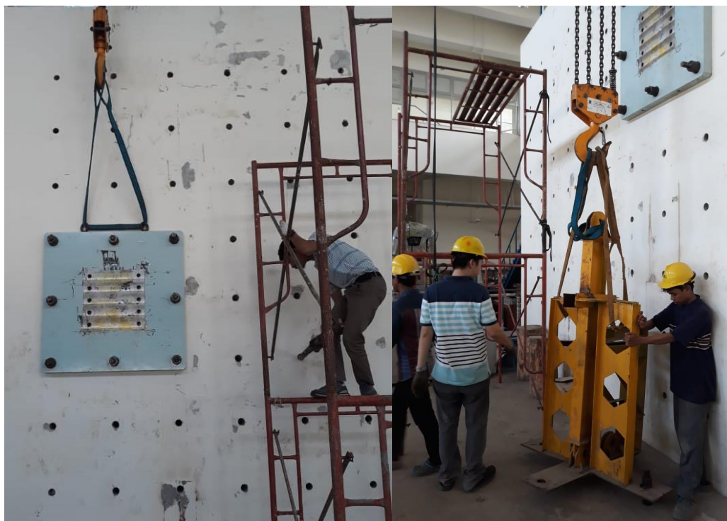
Gambar 4. Pemandangan base plate dan pemasangan pen
