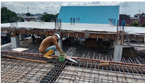
Gambar 5 Pemasangan Mal atau Bekisting
