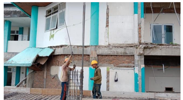
Gambar 6 Pemasangan Besi
