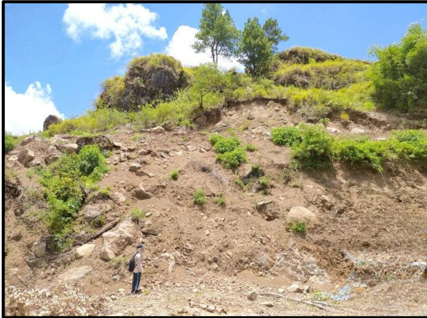
Gambar 2. 17 Kenampakan gerakan tanah berupa debris slide pada difoto kearah N 90° E.
