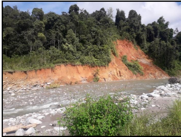
Gambar 2.8 Kenampakan lereng terbuka akibat gerakan tanah ( debris slide ) pada stasiun 43 difoto relatif arah N 295° E.
