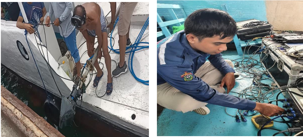
Gambar 2. Proses instalasi alat pada kapal
