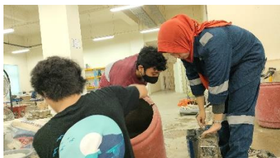
Memasukkan campuran beton kedalam kerucut abrams
