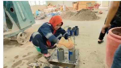
Memasukkan campuran beton kedalam cetakan
