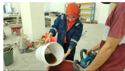
Memasukkan (air + Sikament-NN 1%) kedalam campuran beton
