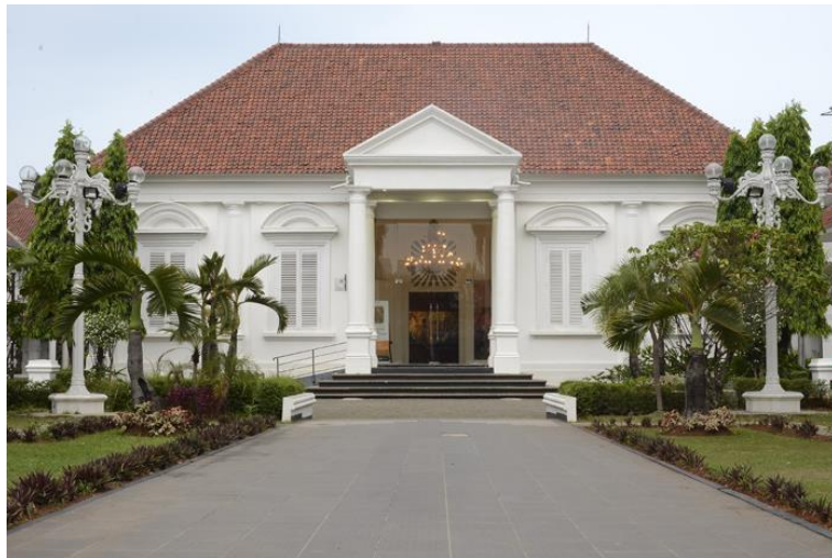
Gambar 2. 15 Gedung A Galeri Nasional Indonesia (Sumber: www.fajar.co.id )
