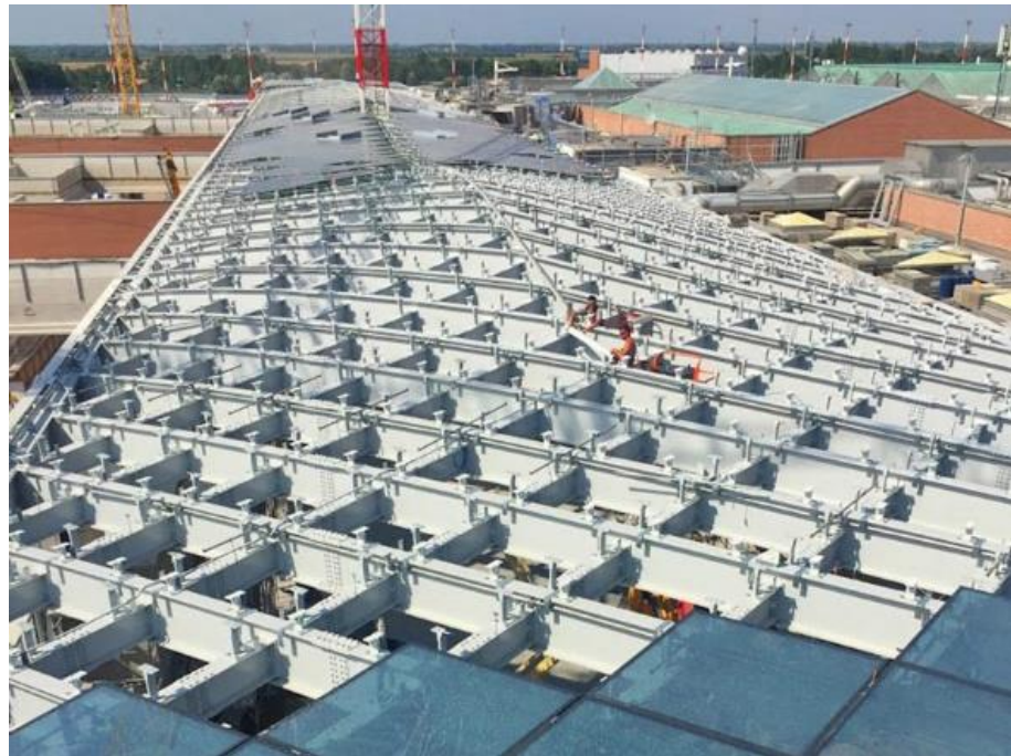
Gambar 38. Konstruksi Atap Galeri Marco Polo Airport. (Sumber: https://www.meweng.com/portfolio/marco-polo-airport-glazing-roof/ , diakses tanggal 5 Juni 2021)
