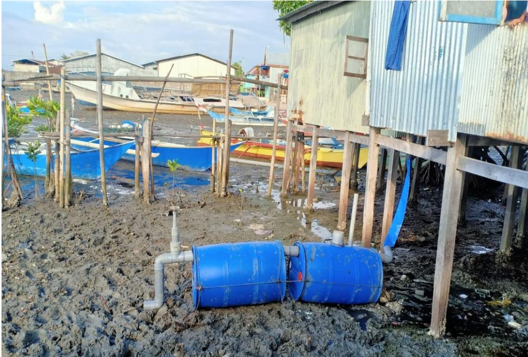
Gambar 4. Pemasangan Septic Tank Apung
