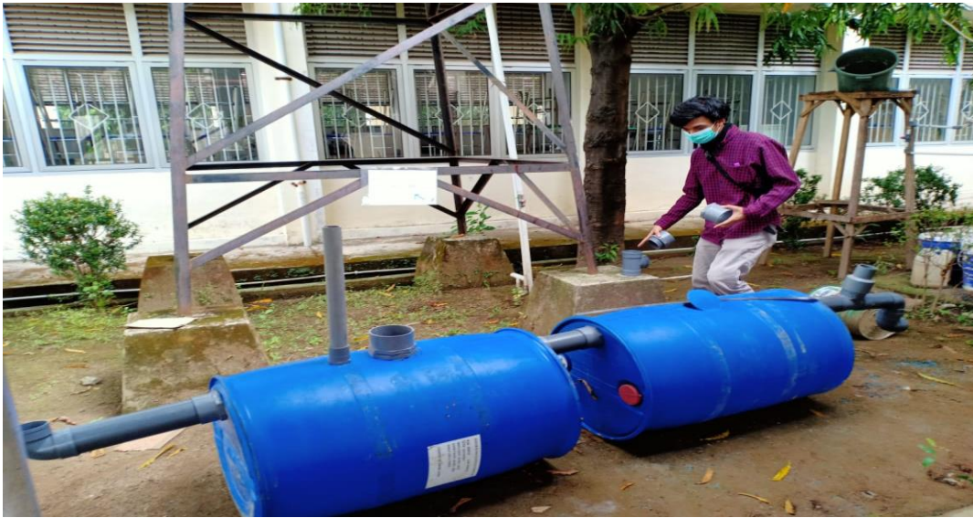
Gambar 3. Proses Pembuatan Septic Tank Apung
