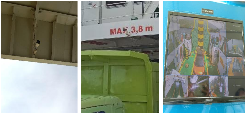
Lampiran 6. Fasilitas Lampu Penerangan Pada Geladak Kendaraan KMP. Opudi
