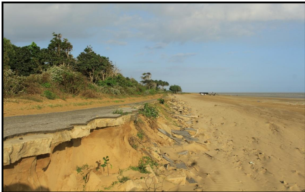
Gambar 5 Ruas Jalan Wendu - Kumbe, Kampung Matara (Sumber : Dokumentasi Pribadi)
