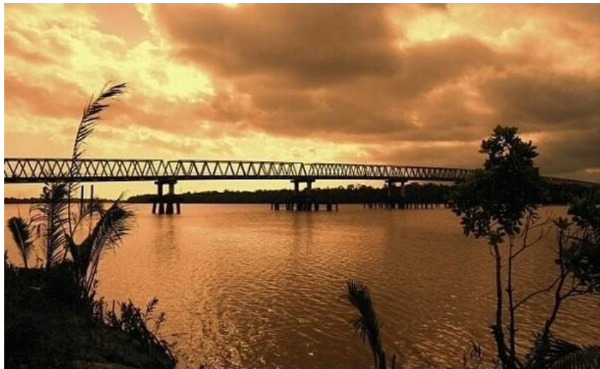
Gambar 10 Jembatan penghubung Kota Merauke dengan Distrik Semangga, Kurik, Tanah miring
