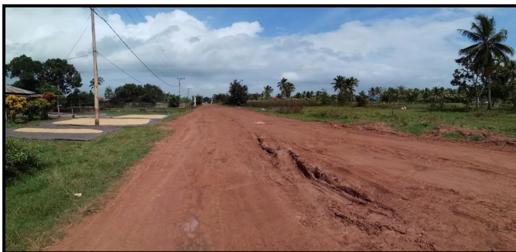
Gambar 6 Ruas Jalan Semangga – Tanah Miring, Kampung Semangga (Sumber : Dokumentasi Pribadi)
