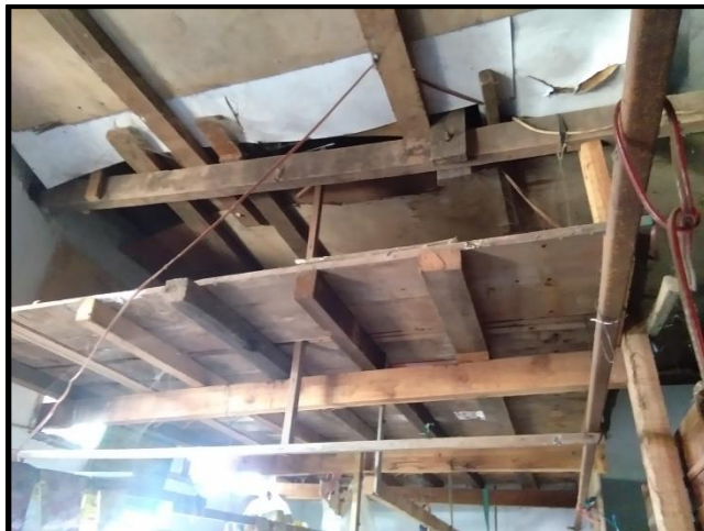
Gambar 8. Adaptasi dengan membuat tempat penyimpanan barang di Nipa-nipa kelurahan manggala
