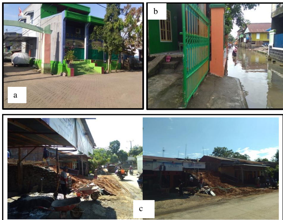
Gambar 6. Adaptasi dengan meninggikan pondasi / lantai rumah
