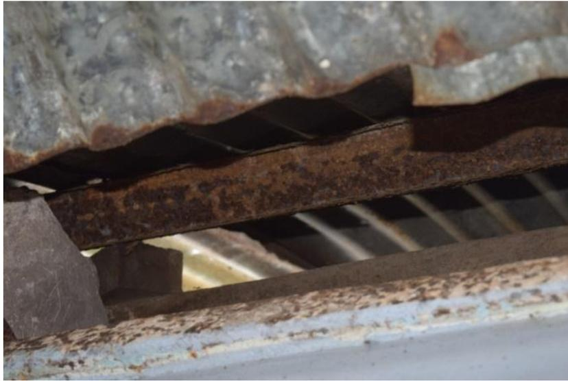
Foto 28: Rangka baja penyatu atap dengan dinding bangunan di jalan Sungai Tangka. ( Dokumentasi, Misna, 2018).
