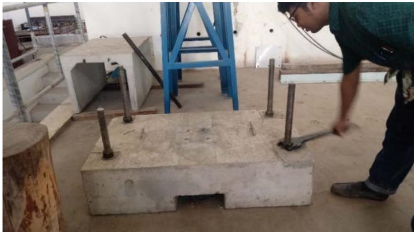
**Gambar 3.11.** Pemasangan *footing*
