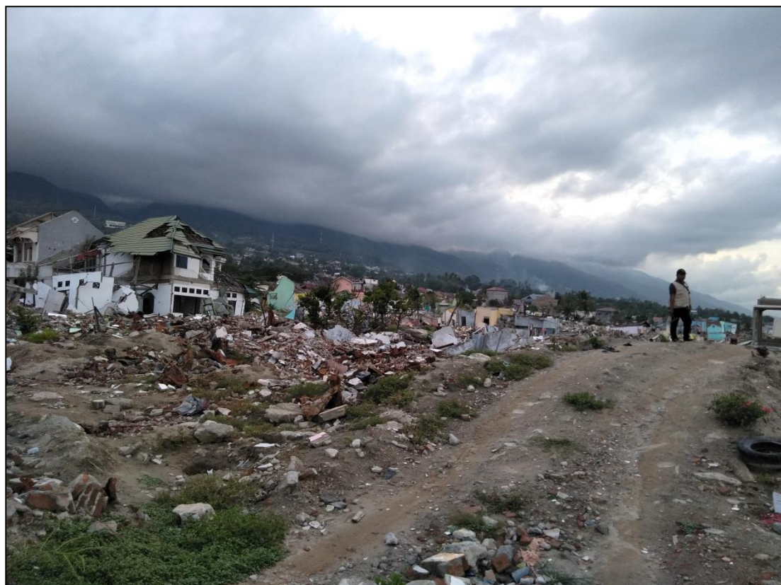
Foto tumpukan material likuifaksi & landslide
