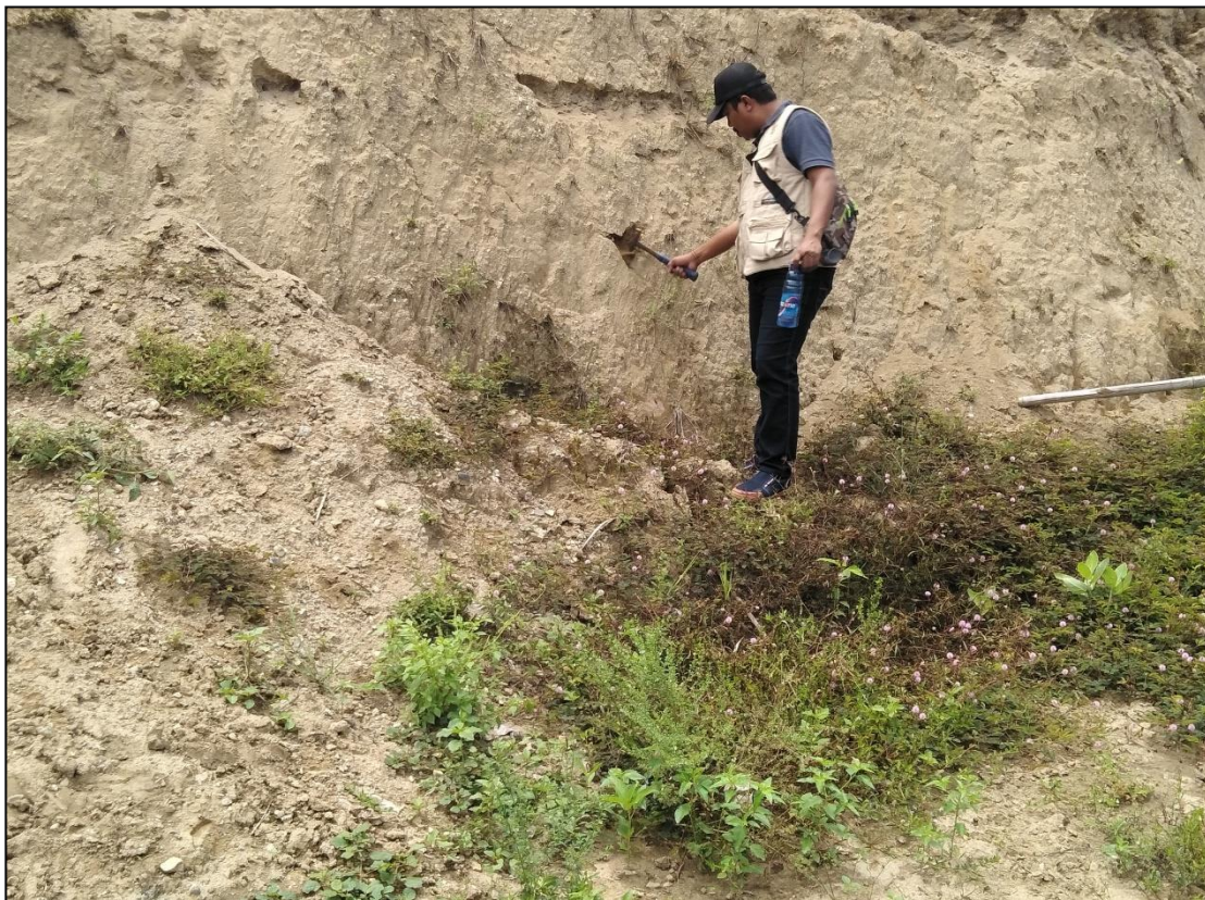
Foto Lokasi yang mengalami Subsidence dampak Likuifkasi
