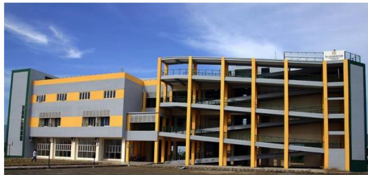
Gambar 13 Gedung evakuasi Tsunami Sumber: Syamsidik dkk, 2019.
