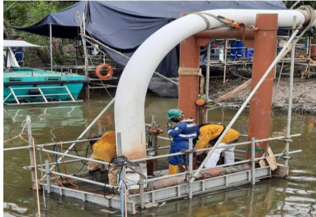
Gambar 2.23 Proses pemasangan riser [24]
