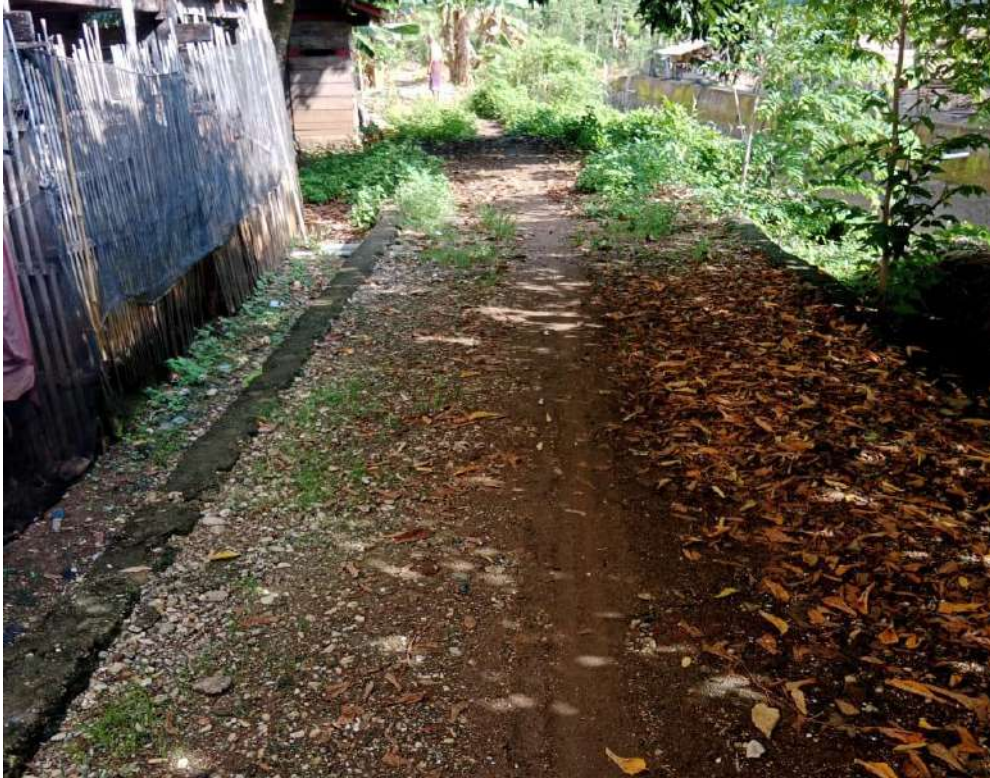
Dokumentasi Pembangunan jalan tani
