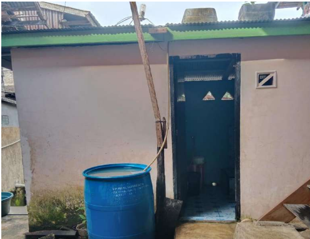
Dokumentasi pembangunan WC
