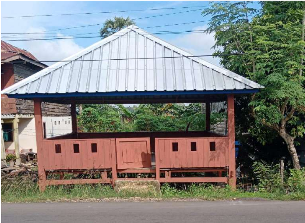
Dokumentasi bangunan pos yandu
