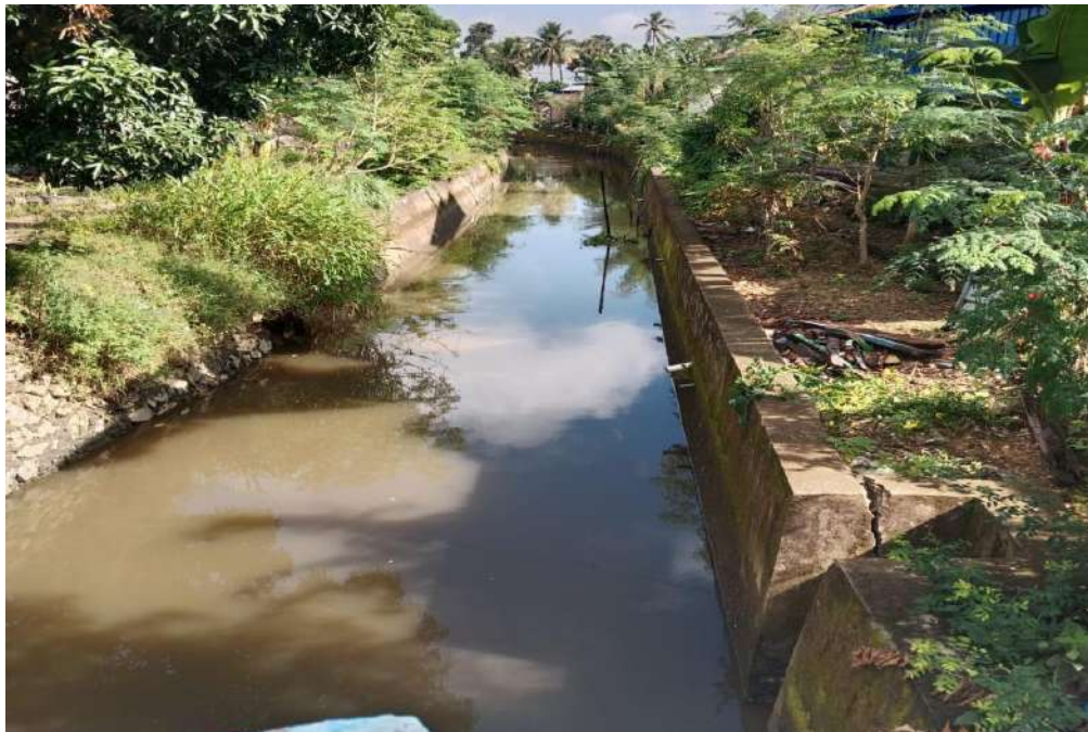
Dokumentasi pembangunan talud
