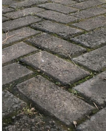
Gambar.1 Aplikasi Penggunaan Paving block Di Lapangan
