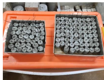
Pembuatan Beton Decking
