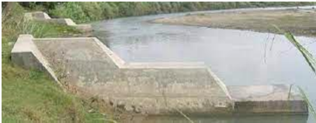
Gambar 6. Krib Impermeabel Dengan Beton
