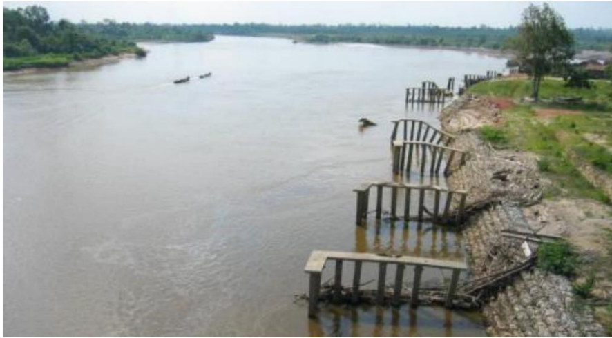
Gambar 5. Krib Permeabel Dengan Tiang Pancang
