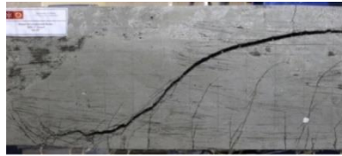
(c) Pola retak pada kegagalan balok R-SP
