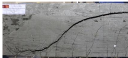
(c) Pola retak pada kegagalan balok R-SP
