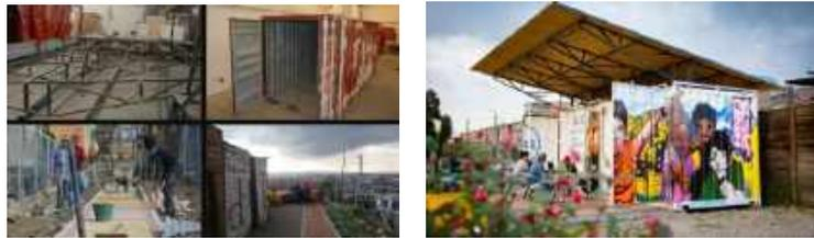
Gambar 2. 41 Penggunaan Kontainer Bekas sebagai Material Konstruksi Bangunan
