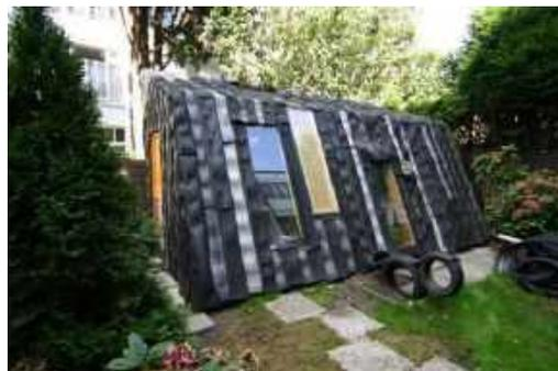
Gambar 2. 33 Ban Mobil Bekas Digunakan Sebagai Pelapis Fasad Bangunan
