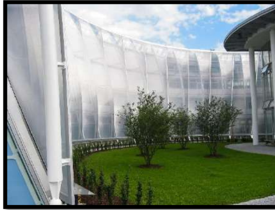
Gambar 13. Centre for Gentorology , Jerman, 2004 (membran ETFE berlapis tunggal sebagai kulit kedua)
