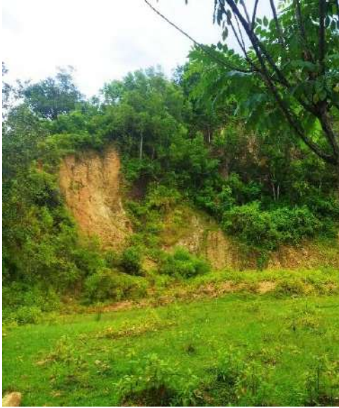
Tanah Longsor 1, dikelilingi oleh penutupan lahan semak belukar
