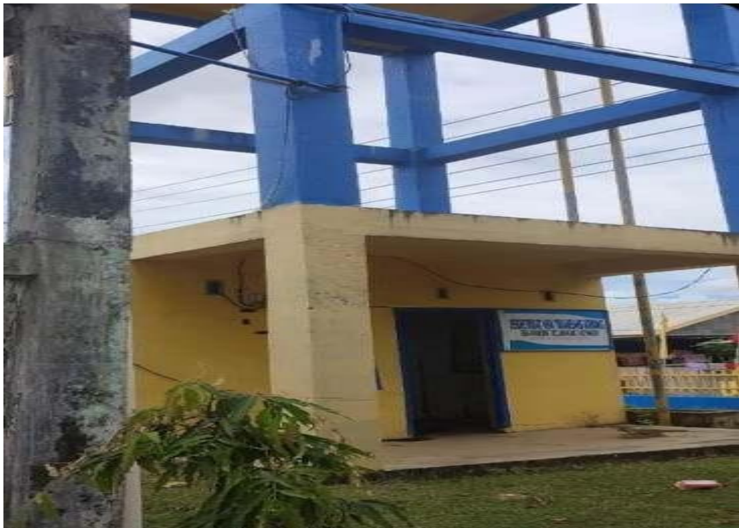
Gambar 3 ( Bangunan Tower Pamsimas Desa Taraweang )
