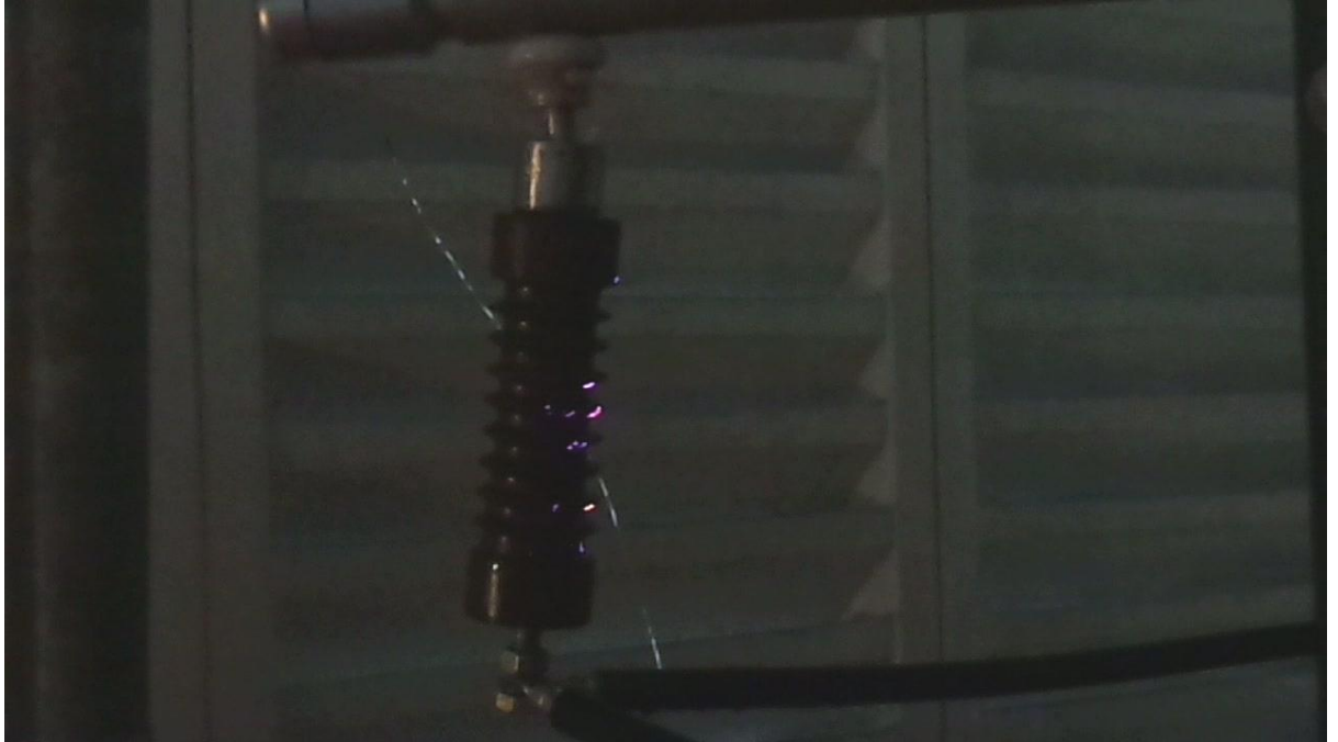
Gambar 6.1 flashover pada isolator resin epoksi
