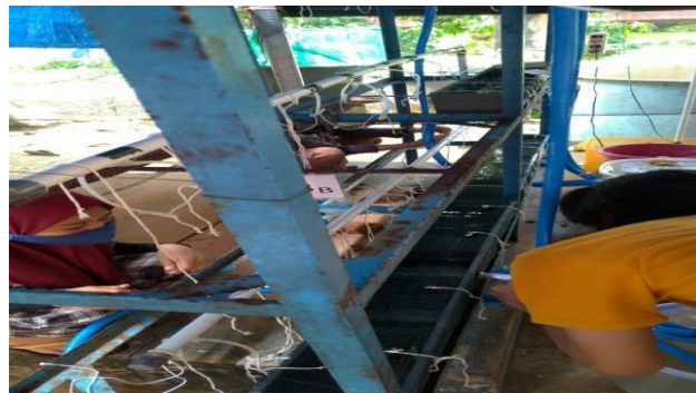
Pemasangan talang air pada arak besi
