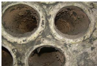
Gambar 8. kondisi ketel uap sebelum dibersihkan menggunakan bahan bakar campuran 60% batubara lignit dan 40% cangkang biji jambu mete
