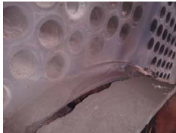
Gambar 9. kondisi ketel uap sebelum dibersihkan menggunakan bahan bakar batubara lignit
