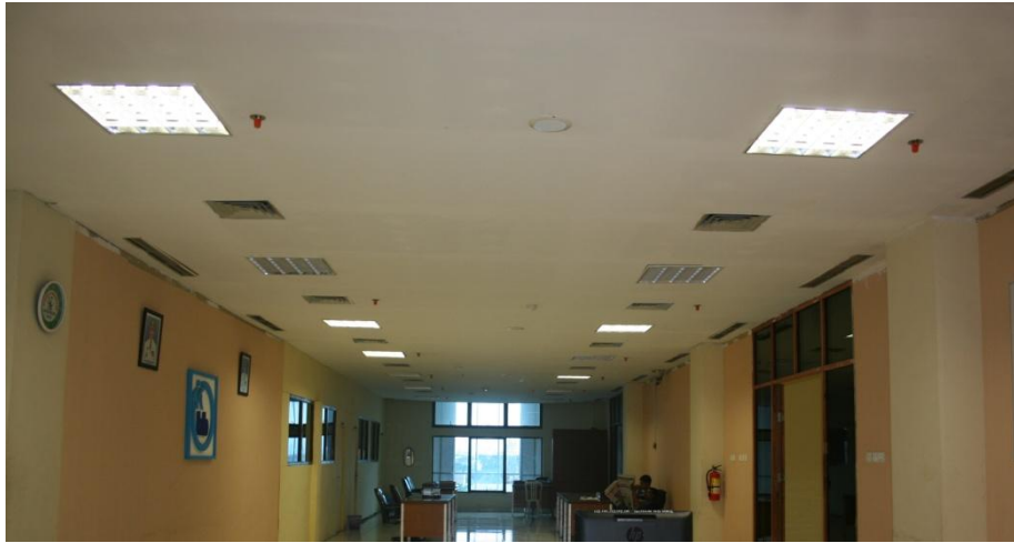
Gambar 60. Plafond Ruang Pegawai Umum Kantor BKKBN Menara Balaikota Makassar
