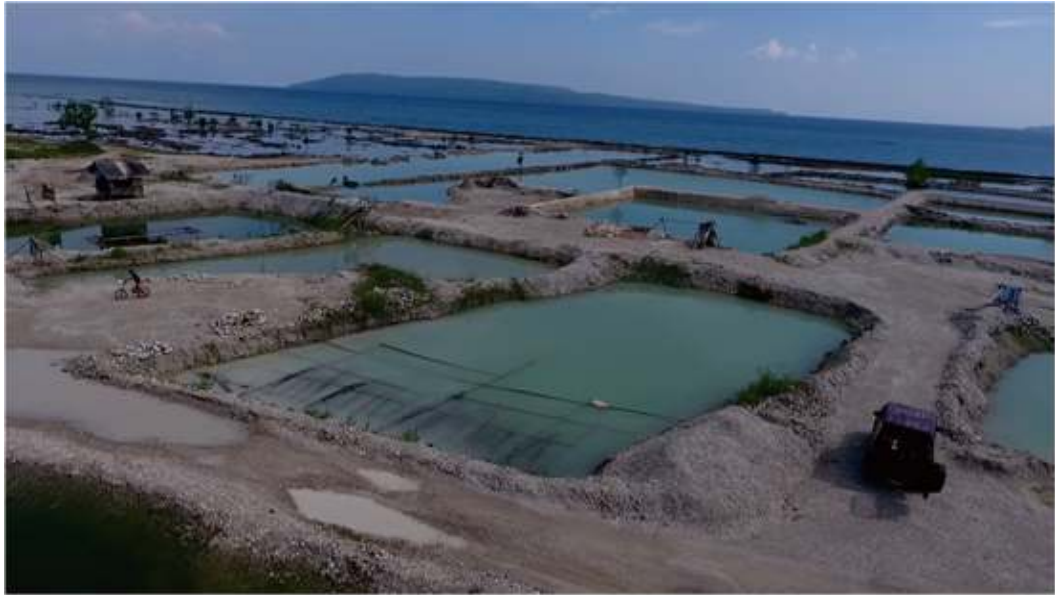
Gambar 3: bekas tambang pasir menyisakan lubang-lubang yang menganga
