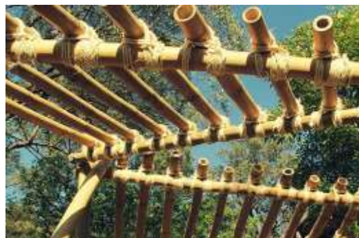
Gambar 5. Sambungan bambu dengan tali
