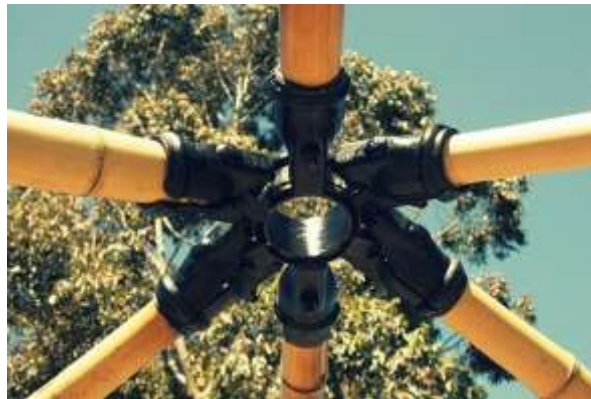
Gambar 8. Sambungan pusat
