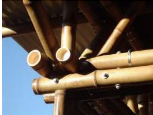
Gambar 6. Sambungan bambu dengan mur-baut
