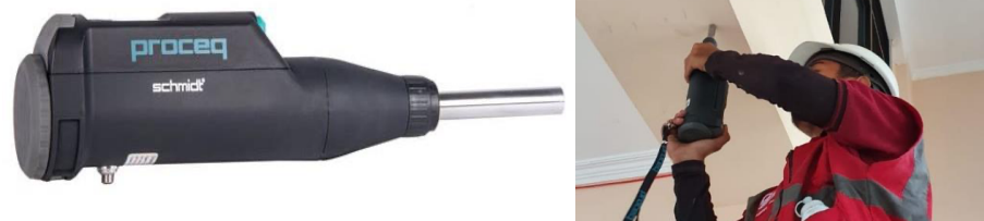
Gambar 2. 5 Alat Schmidt Rebound Hammer Live Digital dan proses pemeriksaan mutu beton balok gedung RS Tahun 2020
