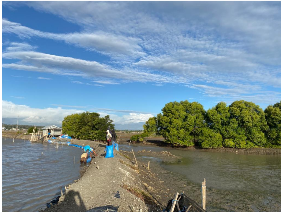
Proses Perbaikan Tambak dari Kebocoran di Kel. Pallengu
