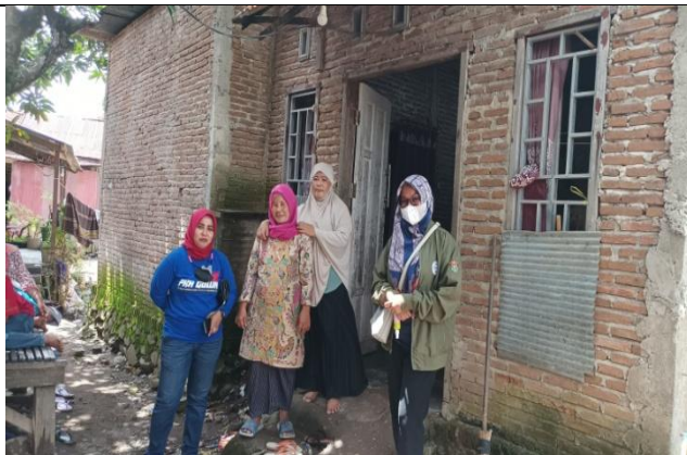
Gambar 7: Kondisi Rumah Informan SDP
