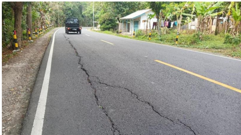
Gambar 2. 4 Retak ( Cracking )
