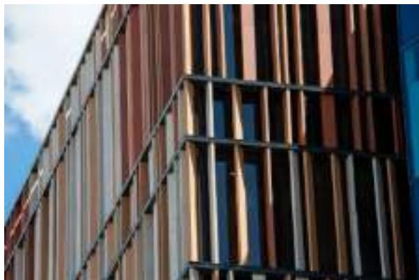
Gambar 9 Shading dan Reflektor
