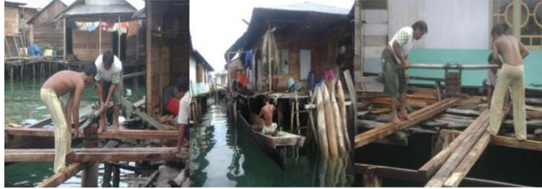
Gambar 11 Penancapan balok penyangga ruas (balok angsale)
