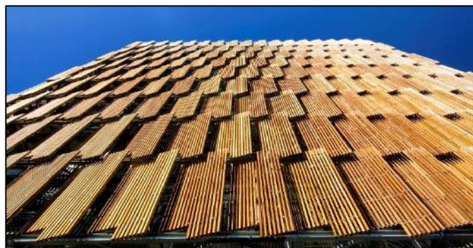
Gambar 30 pengaplikasian kisi-kisi kayu pada City Concil House 2 (CH2) (Sumber : www.archdaily.com , diakses pada 8 September 2021)
