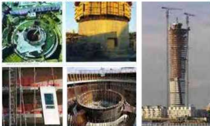
Gambar 2. 12 Proses konstruksi Turning Torso
