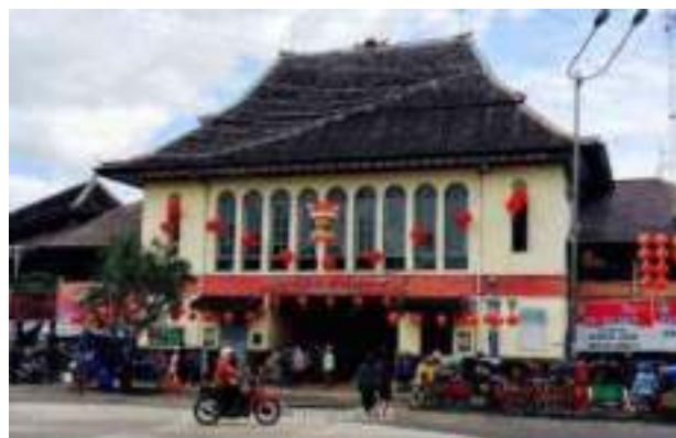
Gambar 2. 13 Tampak Depan Pasar
