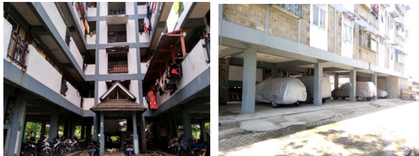
Gambar 2.8 Area Parkir Rusunawa Rajawali Sumber: Dokumen Penulis, 2019
