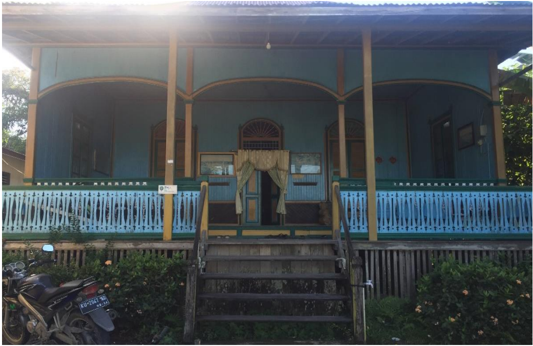
Gambar 2 Ruma Sembau Bulungan Sumber: Analisis Data, 2019
